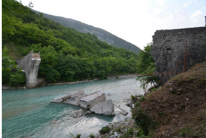
όψη από κατάντη - ανατολικά
