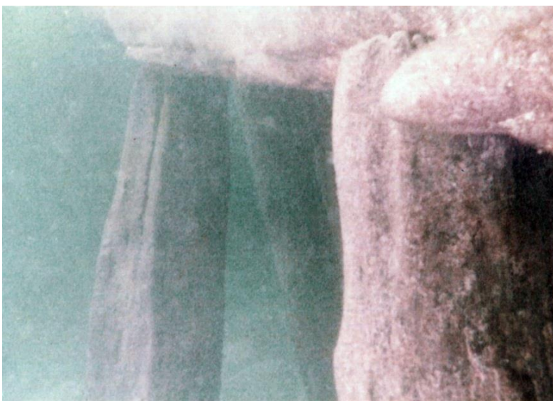
Ξύλινοι Πάσσαλοι Θεμελίωσης Υποβρύχια φωτογραφία Σεπτ. 1983
