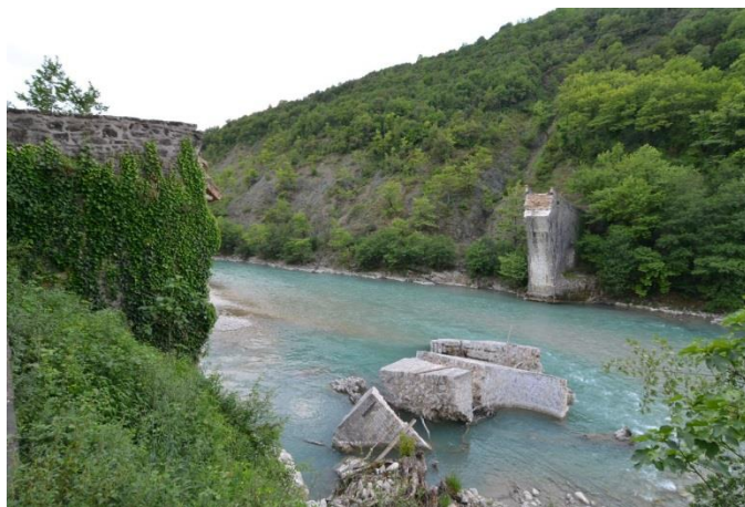
όψη από ανάντη - ανατολικά
