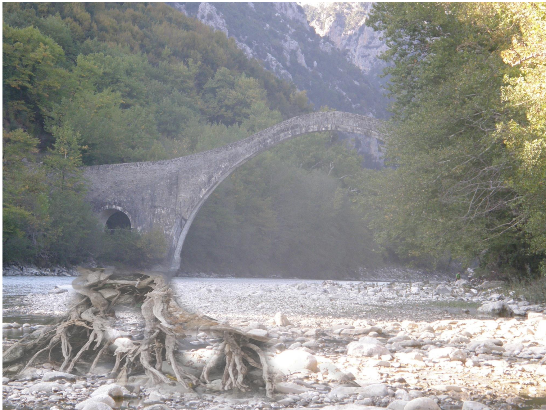
Η ΣΥΜΒΟΛΗ ΤΟΥ Ε.Μ.Π. ΣΤΗΝ ΑΝΑΣΤΗΛΩΣΗ ΤΟΥ ΓΕΦΥΡΙΟΥ ΤΗΣ ΠΛΑΚΑΣ 22-07-2015
