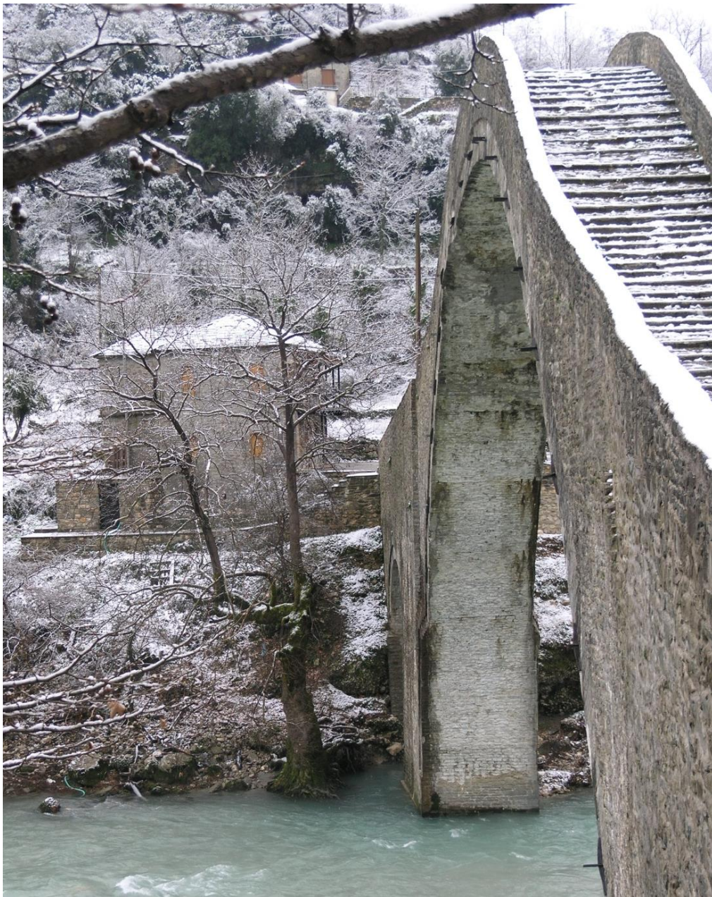
Εικ. 12. Ανάντη πλευρά του αριστερού βάθρου της γέφυρας. Σε απόσταση μικρότερη από ένα μέτρο έχει αναπτυχθεί πλατάνος με σημερινή διάμετρο κορμού στη βάση περίπου 60cm. Το έδαφος μεταξύ του πλατάνου και του βάθρου έχει διαβρωθεί λόγω της τύρβης που δημιουργείται.
