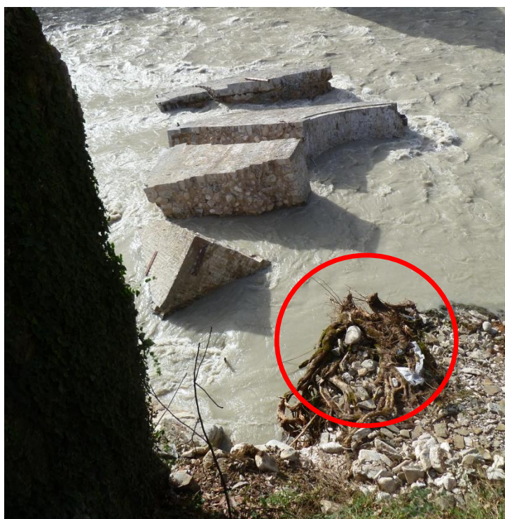
Εικ. 13. Υπολείμματα της ρίζας του πλατάνου (σημειώνονται μέσα στον κόκκινο κύκλο), ακριβώς ανάντη του αριστερού βάθρου της γέφυρας. Εντός της κοίτης φαίνονται τμήματα του αριστερού βάθρου της γέφυρας.
