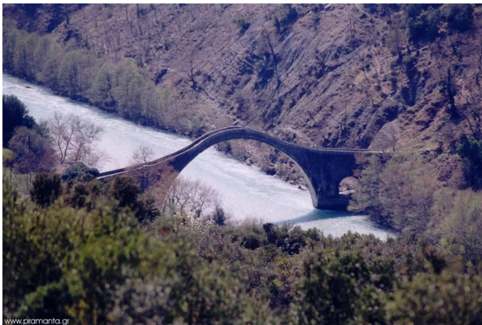
Εικ. 6. Άποψη του δεξιού (δυτικού) αντερείσματος της κοίτης. Το δεξί πρανές στην ευρύτερη περιοχή είναι σχετικά απότομο, λόγω της ευνοϊκής για την ευστάθεια κλίσης της στρώσης του φλύσχη. Πάντως, η επιλογή της συγκεκριμένης θέσης της γέφυρας, δεν προκύπτει ότι έγινε λόγω ευνοϊκών συνθηκών έδρασής της στο δεξί αντέρεισμα, δεδομένου ότι οι γεωλογικές συνθήκες είναι παρόμοιες σε όλο το μήκος του δεξιού πρανούς της κοίτης.
