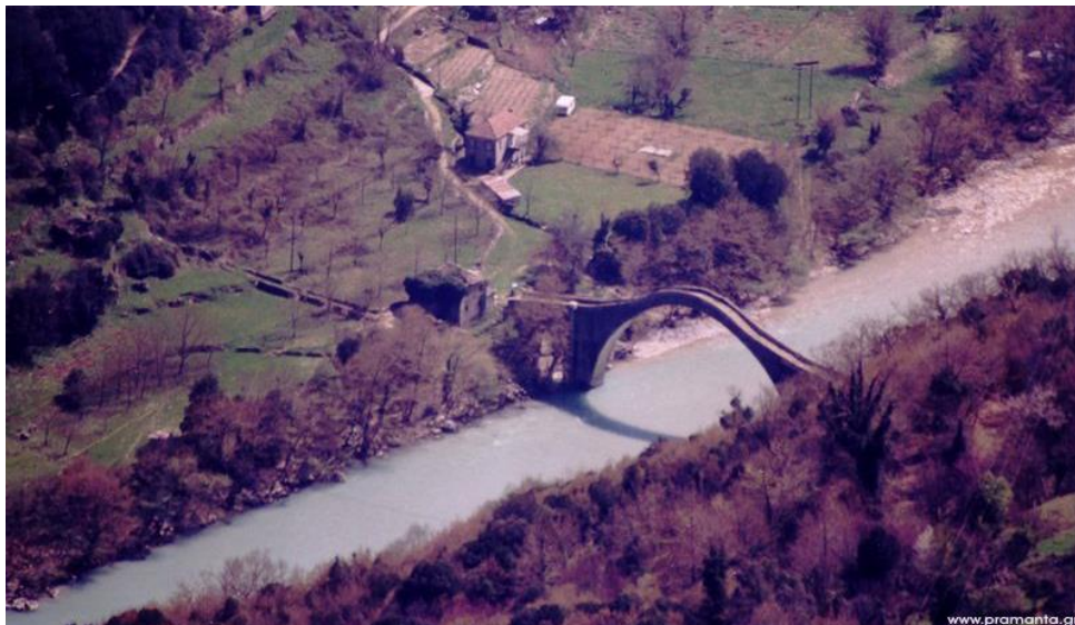
Εικ. 8. Η μορφολογία του εδάφους στην αριστερή (ανατολική) όχθη του ποταμού είναι πολύ ήπια (πεδινό ανάγλυφο) και ο φλύσχος εμφανίζεται εντόνως αποσαθρωμένος επιφανειακά, με αποτέλεσμα οι συνθήκες έδρασης της γέφυρας να είναι δυσμενείς.
